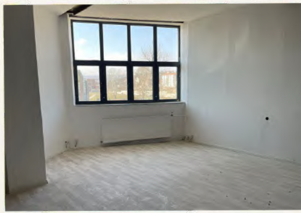
Objekti gjatë procesit të renovimit
