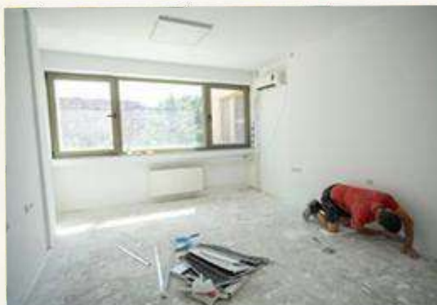
Gjate procesit të renovimit
